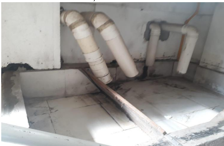
Figura 1 – Sistema de tubulação de calhas
