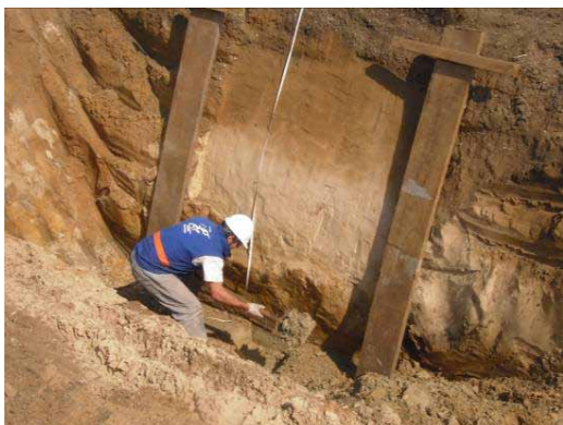
Figura 08: Abertura de trincheiras e limpeza de perfis
