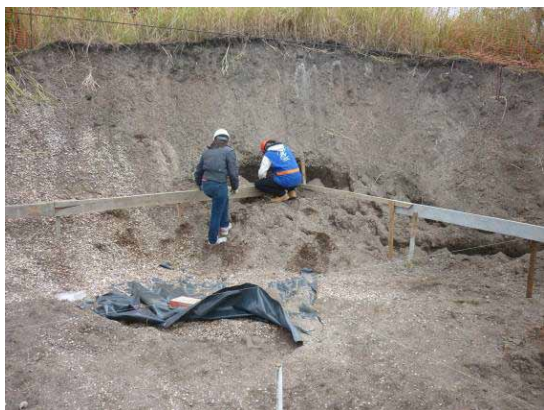
Figura 02: Delimitação da área a ser escavada
