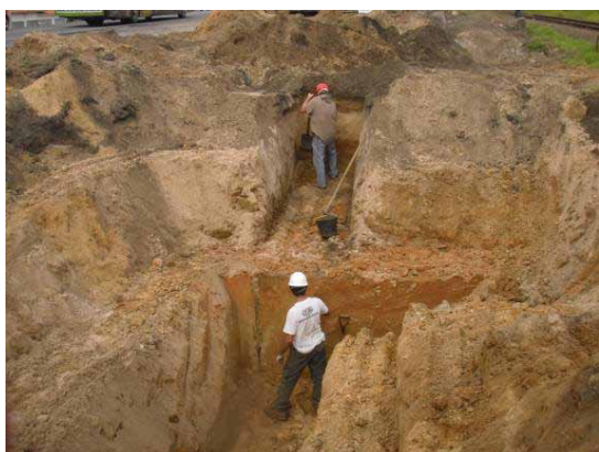
Figura 06: Abertura de trincheiras e limpeza de perfis
